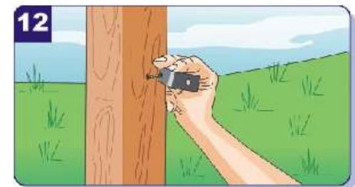
Für die Fixierung der L-Beschläge verwenden Sie Nirosta-Schrauben und ziehen Sie sie mit einem Akku-Schrauber fest.
