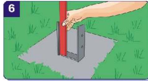
Bevor Sie den Beton vollständig austrocknen lassen, müssen Sie die Pfosten mit Hilfe einer Wasserwaage nochmals ausrichten.
